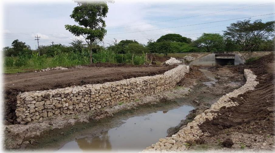
Fase de conformación de sección en Gavión
