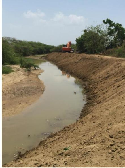
Se evidencia la limpieza y reconfiguración de taludes del cauce del Arroyo Zapata
