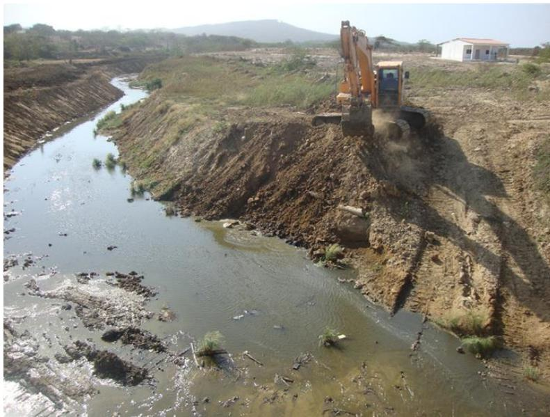
Se evidencia limpieza y reconformación de taludes del Arroyo Grande
